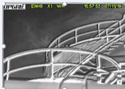
储罐顶部弥散的挥发性有机气体
